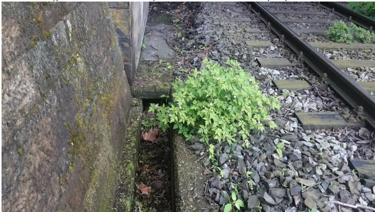
Obrázek č. 3: Výjezd do Loubského tunelu – vyvedení odvodnění tunelu do stáv. příkopu
