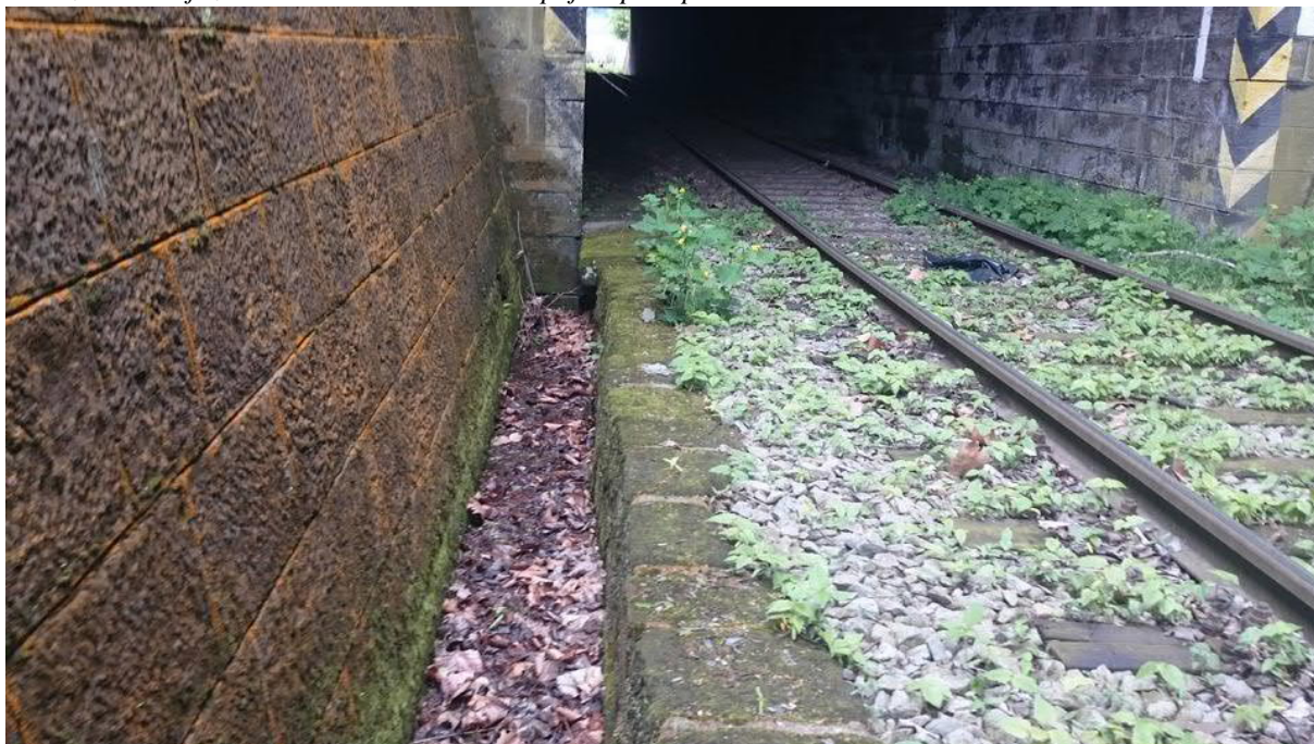
Obrázek č. 2: Vjezd do Loubského tunelu – napojení příkopu na odvodnění tunelu
